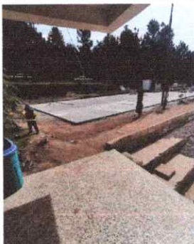
finalizacion de la loza de concreto
