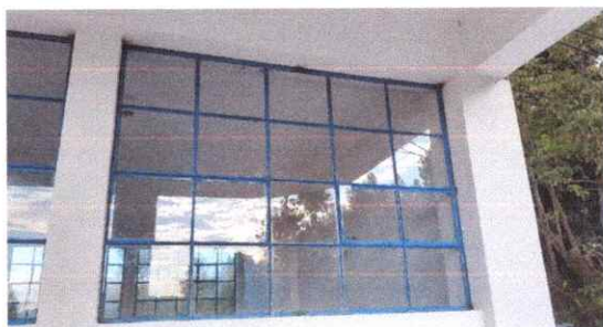
finalizacion de las ventanas
